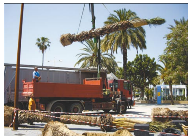
Treballs en les palmeres del barri de Mar
